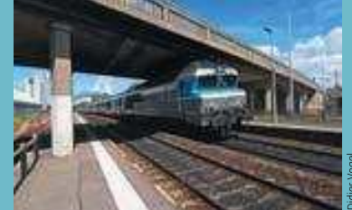
NOGENT-SUR-SEINE. Le pont routier enjambant la gare ferroviaire sera surélevé pour l'électrification de la ligne.
